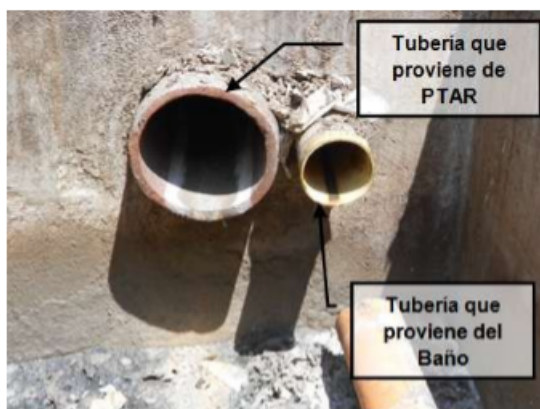
Fotografía 3. Caja de inspección externa predio de la Cr 18 No. 59 – 93 Sur (dirección nueva).
